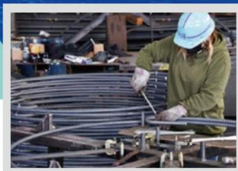
場所打ち杭とは、杭を必要とする現地の地盤に孔を掘り、その中に鉄筋かごを入れ、コンクリートを打設し、地中でRC（鉄筋コンクリート）杭を築造する工法です。
